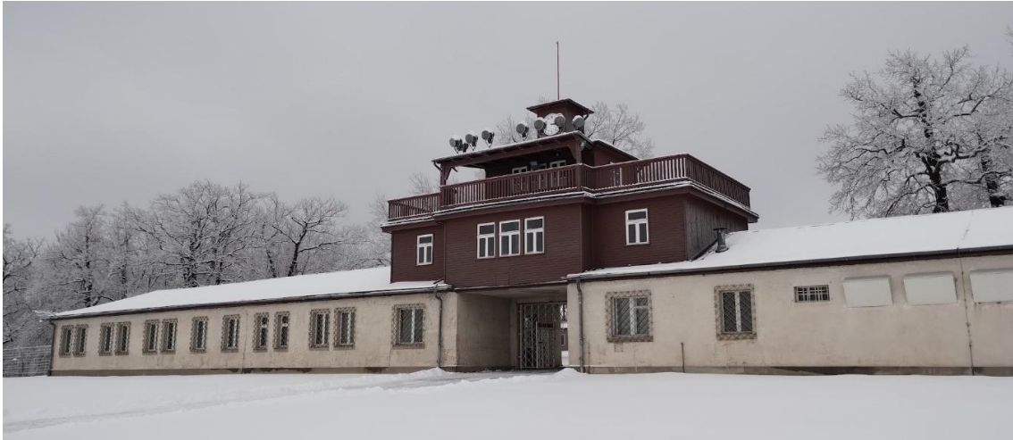
Portón desde el interior del sector de prisioneros. © CEF
